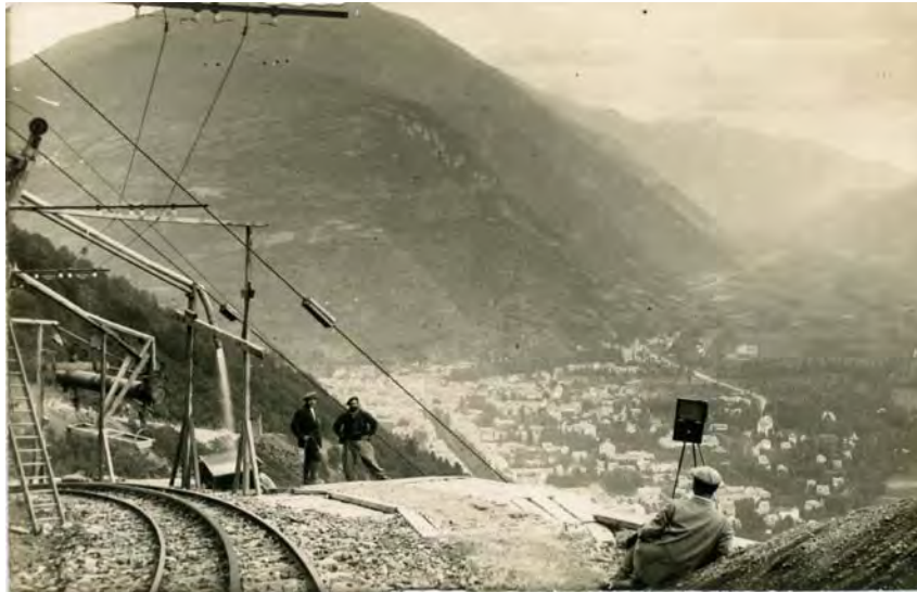
Figure 1 – 'Prise de vue d'une prise de vue' Carte photo montrant la réalisation d'une prise de vue vers 1900 lors de la construction du funiculaire reliant Bagnères de Luchon à Superbagnères. Coll. V. Dubost
