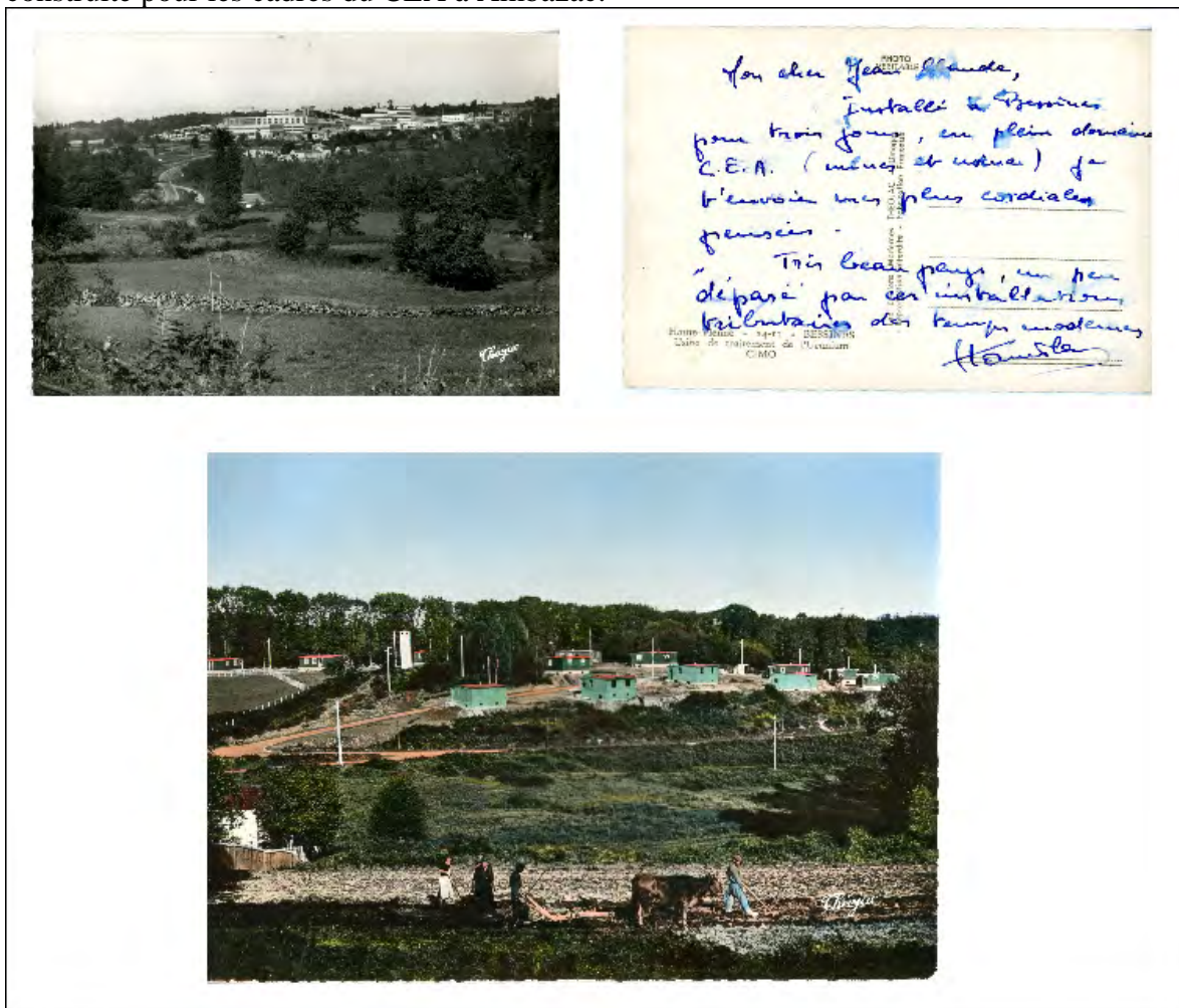
Figure 28 – En haut : vue de l'usine SIMO de Bessines sur Gartempe Au verso, le texte mentionne 'Mon cher Jean-Claude. Installé à Bessines pour trois jours, en plein domaine C.E.A. (mines et usine) je t'envoie mes plus cordiales pensées. Très beau pays, un peu déphasé par ces installations tributaires des temps modernes'. Vue de la cité construite à Ambazac pour les cadres et ingénieurs du CEA. Au premier plan, de manière probablement volontaire, l'évocation de l'agriculture traditionnelle limousine. Cartes Photo. Coll. V. Dubost
